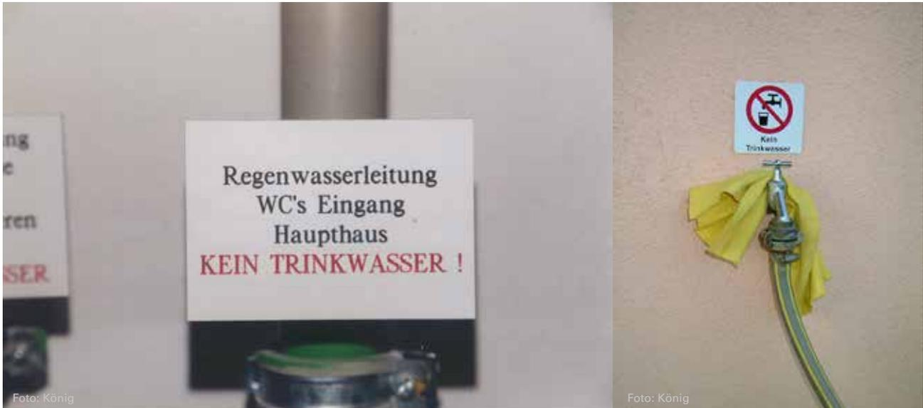
Rohrleitungen für Regenwasser sowie frei zugängliche Zapfhähne bzw. Entnahmeventile müssen mit Schildern oder Aufklebern eindeutig (und farblich unterschiedlich zu Trinkwasser) gekennzeichnet sein. Die Kontrolle erfolgt laut DIN 1989-1 im Rahmen der Inspektion einmal jährlich.
