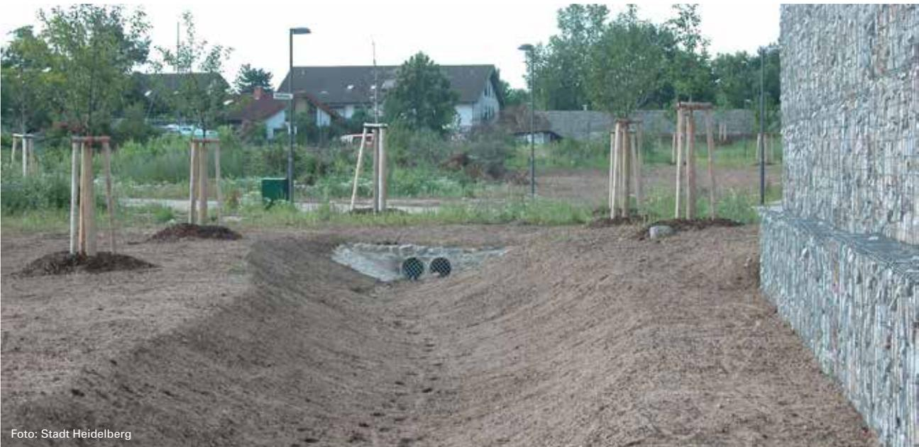
Hier werden die kombinierten Maßnahmen sichtbar: Die Versickerungsmulde mit einer Muldenverbindung. Auf der rechten Seite ist eine Gabionenwand zu sehen, die als Lärmschutz und auch als Lebensraum für Kleintiere fungiert.
