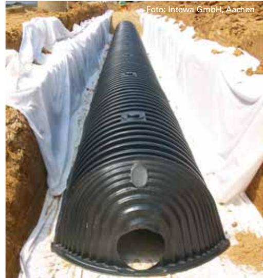
Regenwasserversickerung mit Tunnelementen.
