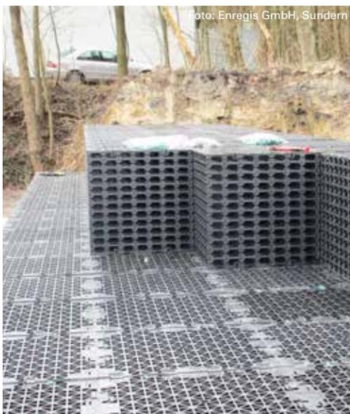
Aufbau einer Regenwasser-versickerungsanlage.
