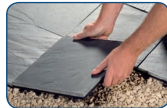
Kinderleichte Verlegung in kürzester Zeit.
