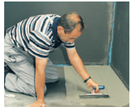
Mit PCI Lastoflex abgemischte Verlegemörtel bauen Untergrundspannungen ab und gleichen Spannungen infolge von Temperaturschwankungen aus.
