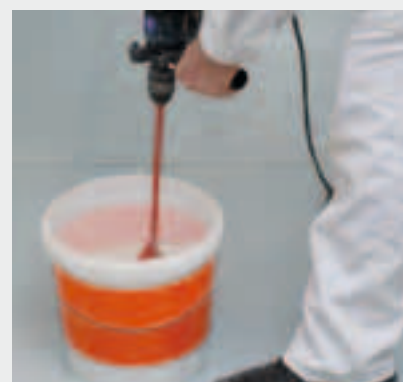
Mit geeignetem Rührgerät bei langsamer Drehzahl anmischen, bis eine homogene, klumpenfreie Nivelliermasse entsteht
