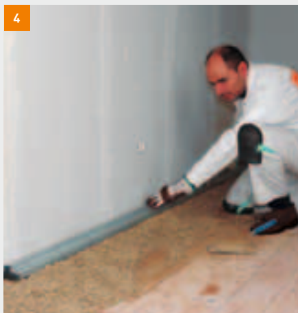
4 Der erste Damm wird angelegt und ausgerichtet
