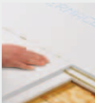
Verkleben der Elemente mit vollständig gefüllten Fugen
