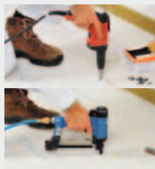
Befestigen durch Verschrauben ... oder Spezial-Spreizklammern innerhalb von 10 Min.
