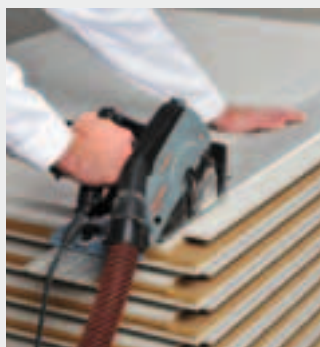
Absägen des überstehenden Falzes für die erste Verlegetreihe
