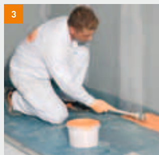
fermacell Flüssigfolie in die Ecke auftragen
