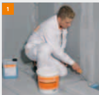
fermacell Tiefengrund im angrenzenden Wandbereich ...
