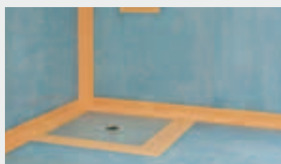
Sind die Powerpanel TE FußbodenElemente verlegt, verklebt und verschraubt, wird die Fläche mit fermacell Voranstrich eingestrichen und in den Anschlussbereichen das Abdichtungssystem eingesetzt
