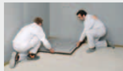
Variante A: Man zieht in Höhe der Oberkante des Ablaufgehäuses die gesamte Fläche mit der gebundenen Schüttung ab und setzt das Duschelement
