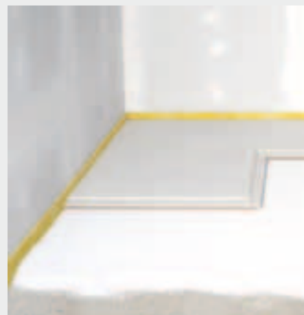
Verlegen der fermacell Estrich-Elemente auf fermacell Ausgleichsschüttung
