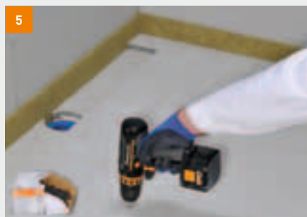
5 Abdeckplatte fixieren und umlaufende Fläche mit geeigneten Materialien an das Gefälle-Set anpassen. fermacell Powerpanel TE durchgehend verlegen
