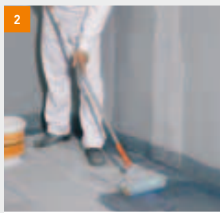
... und Bodenbereich per Rolle auftragen
