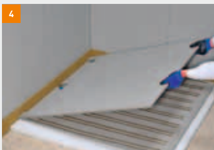
4 ... und die zugeschnittene Powerpanel H 2 O Abdeckplatte auflegen
