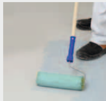
Vorbereitung: Boden grundieren
