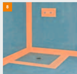
Beim Powerpanel TE Bodenablauf wird in den Anschlussbereichen das Abdichtungssystem eingesetzt
