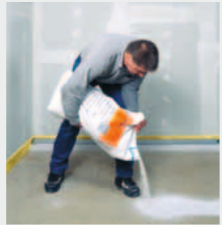
Anlegen der Dämme
