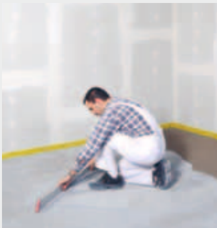
fermacell Wabenschüttung abziehen
