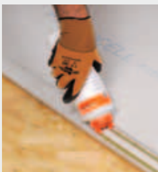
Auftragen des fermacell Estrich-Klebers im Falzbereich
