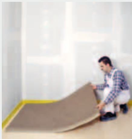
fermacell Estrich-Wabe verlegen
