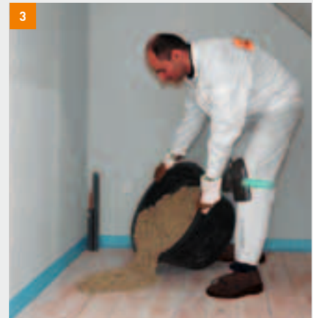
3 Anschließend hat die gebundene Schüttung eine erdfuchte Konsistenz
