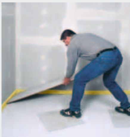
Verlegen der fermacell Estrich-Elemente auf fermacell Ausgleichsschüttung
