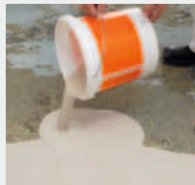
Boden-Nivelliermasse ausbringen und planeben nivellieren
