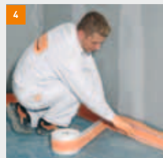
In die feuchte Flüssigfolie das fermacell Dichtband eindrücken
