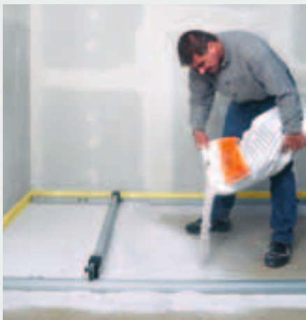
fermacell Ausgleichsschüttung einbringen
