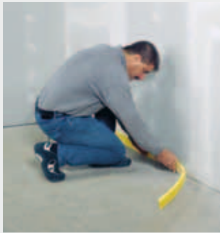
Anbringen der Randdämmstreifen
