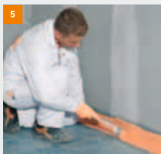
Dichtband direkt nach dem Eindrücken mit fermacell Flüssigfolie überstreichen
