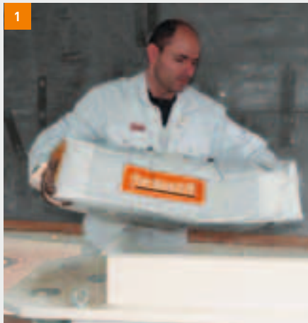
1 Der gesamte Sackinhalt ist in einem geeigneten Mischgerät ...
