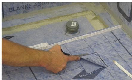
**8** Der Anschluss muss auf die folgende DIBA Bahn angezeichnet und ausgeschnitten werden.
