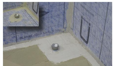
**9** Nun müssen die Bodenmanschette und die Dichtbänder mit BLANKE DIBA-COLL appliziert werden und die Fläche mit einem Dünnettörtel C2/S1. Nun kann die DIBA Dichtbahn über die Anschlüsse geschoben, sowie blasen und faltenfrei in DIBA-COLL und Dünnettörtel eingebettet werden.
