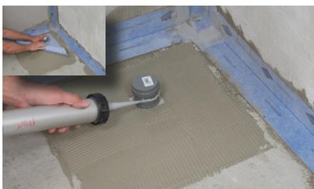
**7** Direkt um den Anschluss (Abflussrohr) BLANKE DIBA-COLL auftragen, auf der Bodenfläche in Flanschgröße einen Dünnettörtel C2/S1 aufkämmen, Flansch mit dem Ausschnitt über den Anschluss ziehen sowie blasen und faltenfrei in Dünnettörtel Einbetten.
