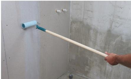
**1** Die für das BLANKE DIBA System vorgesehenen Flächen sind dem Untergrund entsprechend zu Grundieren. Es ist darauf zu achten, dass die Rohrverlängerung auf den fertigen Belag abgestimmt, eingebaut ist. Ein Eindichten von Baustopfen ist nicht zulässig.
