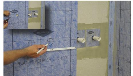
**3** Die Anschlüsse müssen nun auf die darauf folgende DIBA Bahn angezeichnet und ausgeschnitten werden.
