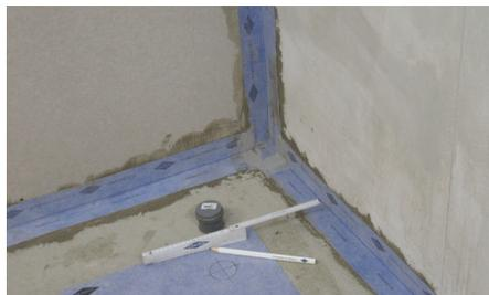
**5** Den Anschluss (hier ein Abfluss) auf die 45 x 45 cm große Bodenmanschette anzeichnen, hierbei auf 50 mm Abstand bis zum Flanschrand für die Überlappung achten.
