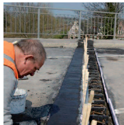
Ausbildung einer Strassenübergangskonstruktion mit PCI Repafast® Fibre
