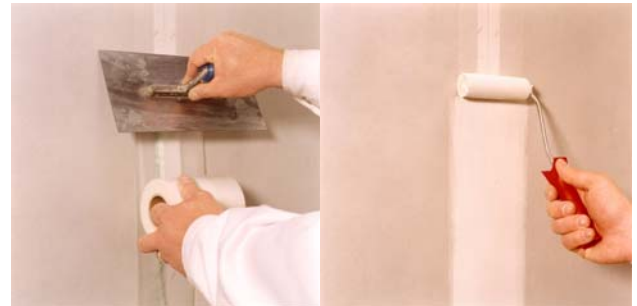
Aufbringen des FERMACELL Armierungsbandes HD
