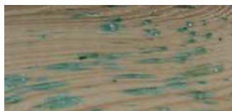
Ausblühen von Imprägniersalzen
