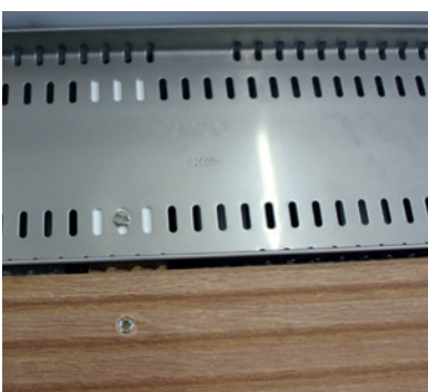
Verschraubung des Rinnenkörpers durch die 4 mm Drainschlitze im Rinnenboden
