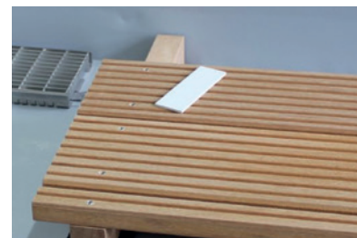
Rinnenkörper nach Notwendigkeit bau-seits unterfüttern
