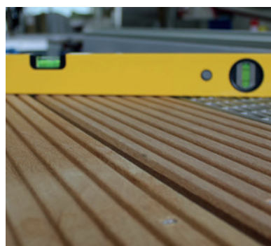
Kontrolle der Einbauhöhe
