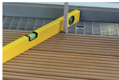
Einpassen der Holzterrassenrinne
