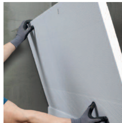
Mit PCI Barraseal Turbo können auf den erhärteten Untergrund Drain- und Dämmplatten geklebt werden.
