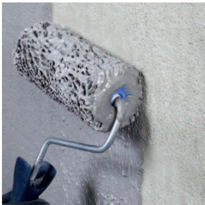
Aufbringen einer Kontaktschicht mit dem Roller.
