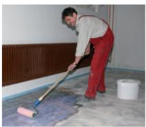
PCI Gisogrund Rapid wird mit einer feinporigen Schaumstoffwalze unverdünnt und gleichmäßig satt auf den mineralischen Untergrund aufgetragen. Nach der Verfilmung können sofort die nachfolgenden Arbeiten ausgeführt werden.
