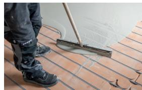
Beim ersten Vergießen wird die NORIT-Vergussmasse CA auf der grundierten Fläche verteilt und auf den Platten flächenbündig abgezogen. Das Zweite Vergießen erfolgt nach ca. 50 Minuten, nach Antrocknen der ersten Schicht. Hierbei wird die Vergussmasse mit der NORIT-Rakel mit 3 mm Überstand abgezogen. Das zweite Vergießen erfolgt dabei ohne vorheriges Grundieren.
