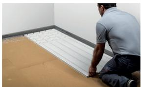
Bei der Verlegung ist auf eine geschlossene Fuge zu achten. Per Hand kann die Nut-Feder Verbindung der Platten zusammengeschoben werden. Dehnungsfugen sind erst ab einer Raumlänge von 20 m vorzusehen. Randplatten können mit Hilfe eines TE-Zugeisens leicht eingesetzt werden. Nach Abschluss der Arbeiten müssen evtl. gesetzte Keile entfernt werden. Zur Vorbereitung auf die folgenden Arbeitsschritte muss die Fläche staubfrei und frei von Verschmutzungen sein.
