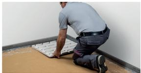
Die erste Plattenreihe wird wandseitig auf die Schleppfolie gelegt. Dabei zeigt die Feder zum Randdämmstreifen und die Nut in den Raum. Wandseitig muss die Feder nicht abgeschnitten werden.
