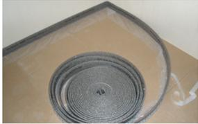
Vor der Verlegung der NORIT-TE Therm Elemente wird umlaufend der NORIT-Randdämmstreifen angebracht. Die daran befestigte Folie wird voll ausgebreitet in den Raum gelegt. In Ecken wird die Folie überlappt. An Kanten wird eine zusätzliche Folie zur Abdichtung angebracht. Das Abkleben von Stößen des Randdämmstreifens und der Schleppfolie ermöglicht ein sicheres Vergießen der Fläche.
