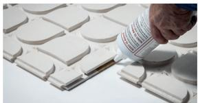
Der Klebstoffauftrag erfolgt mit der Klebstoffspitze in die raumseitige Nut. Nach Auftrag des NORIT-TE-Klebstoffs (ca. 30 g/m<sup>2</sup>) werden die nächsten Elemente gerade angesetzt und mit leichtem Druck gegen die bereits verlegte Platte geschoben.
