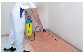
Die rötliche Grundierung wird mit einem Drucksprüher gleichmäßig aufgebracht. Um auch die Flanken der Ausfräsungen vollständig zu grundieren, wird das kreuzweise Sprühen aus mehreren Richtungen empfohlen. Die NORIT-Grundierung wird
