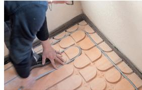
Das NORIT-Heizrohr wird nach der Vorgabe des Fachplaners verlegt. Es ist darauf zu achten, dass das Rohr sauber in die *fix*-Führung einklickt, es darf nicht verdrehen oder knicken. Die max. Heizkreislänge kann durch die laufende Markierung auf dem Rohr kontrolliert werden. Wird das Heizrohr durch aufsteigende Bauteile oder Zwischendecken verlegt, muss dies durch ein geeignetes Schutzrohr geführt werden.
