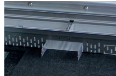
Ansetzen der Rinnen mit der Auskragung zum Anschlussbereich
