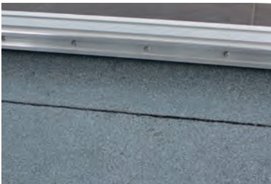
Anschluss einer bituminösen Abdichtung mit Keilausbildung
