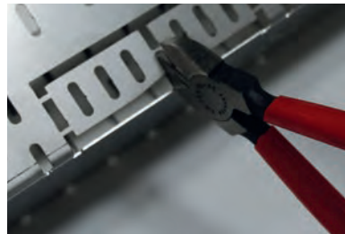
Öffnen des Stichkanalanschlusses
