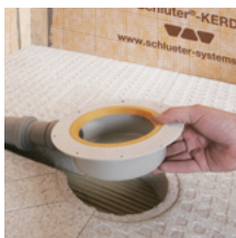
zu 3.: Ablaufgehäuse einsetzen
