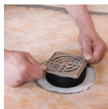
zu 9.: Edelstahlrost mit Unterbau im Zuge der Verlegung höhengerecht einsetzen
