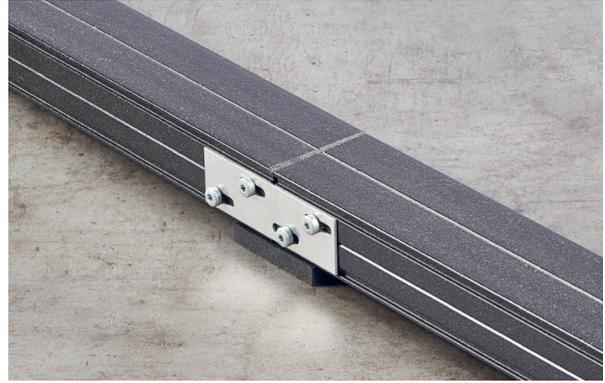
Bei Längsstößen der Unterkonstruktion muss der Abstand zu festen Bauteilen eingehalten werden. Zusätzlich müssen je Längsstoß immer mind. 1 cm Luft eingeplant und berücksichtigt werden. Verwenden Sie Verbindungselemente mit Langlöchern, damit eine Längenausdehnung gewährleistet ist.
