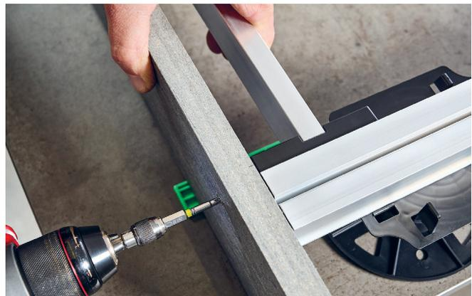
Blendenbefestigung mit Adapter für Queraussteifung
