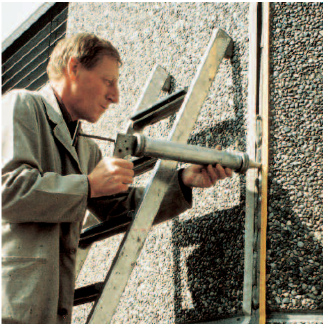
Schließen einer Bewegungsfuge mit PCI Elritan 100 an einer Waschbetonfassade.
