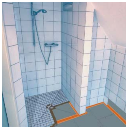
Abb. 7: Bodenflächen sowie barrierefreie Duschen können mit fermacell Powerpanel TE Estrich-Elementen erstellt werden.
