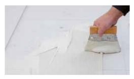
Der Flächenklebstoff wird mit einer Zahnspachtel (Zahnung B3) im Zuge der Verlegung für das nächste Element aufgetragen.
