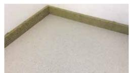
Die Verlegung erfolgt schwimmend und beginnt immer in der linken Raumecke mit der Federkante in Richtung Rand. Die Feder ist im Randbereich zu entfernen.
