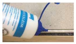
Der Systemkleber ist jeweils an der unteren Nutwange des bereits verlegten, sowie auf der Oberseite der Feder des neu zu verlegenden Elementes aufzutragen. Der Klebstoff muss an der Oberseite austreten.
