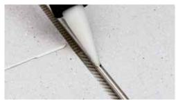
Auch bei der Verlegung der zweiten Lage sind die Nut/Feder-Verbindungen wie bei der ersten Lage zu verkleben.
