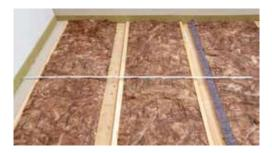
Um eine planebene Auflage für GIFAfloor PRESTO herzustellen, werden beispielsweise Holzbohlen seitlich an die vorhandenen Balken angeschraubt. Die Anflanschung kann einseitig (≥ 40 mm) oder beidseitig (≥ 30 mm) montiert werden. Die Tragkonstruktion muss die der Nutzung entsprechende Mindesttragfähigkeit besitzen. Der statische Nachweis ist bauseits zu erbringen.
