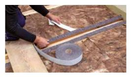
Auf die nivellierten Balken die Auflagerdämmstreifen kleben. Zwischenräume bis ca. 1 cm unterhalb der Oberkante der Anflanschung dämmen. Vorhandenes Schüttmaterial kann in der Regel verbleiben. Den Randdämmstreifen an der Wand befestigen oder das Schaumband an die Gipsfaserkante kleben.
