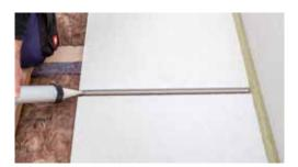
Die Nut/Feder- Verbindungen sind sorgfältig mit Knauf Systemkleber zu versehen und press zu stoßen. Bei zweilagigen Systemen bitte Nut/Feder-Klebstoff verwenden.
