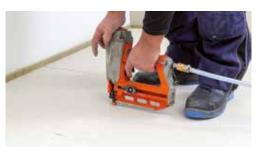
Die zweite Lage unmittelbar nach der Einbettung ins Kleberbett auf der unteren Lage fixieren. Hierzu bei der Nagelung mit Druckluft-/Impulsnagler auf dem zu befestigendem Element stehen und dadurch durch das eigene Körpergewicht die zweite auf die erste Lage pressen.
