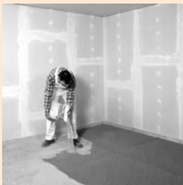
FERMACELL Wabenschüttung einbringen
