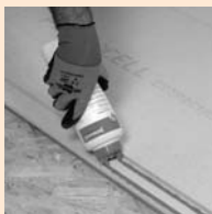
Verkleben der Falze mit FERMACELL Estrich-Kleber
