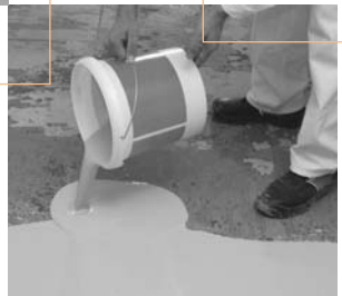
Boden-Nivelliermasse ausbringen und planeben nivellieren
