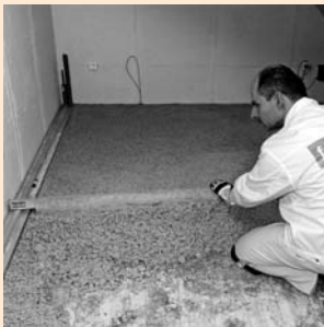
Ist die gebundene Schüttung zwischen den Dämmen ausgebracht, wird abgezogen
