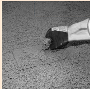
Mit der Glättkelle werden Unebenheiten egalisiert
