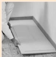
Verlegen der FERMACELL Estrich-Elemente
