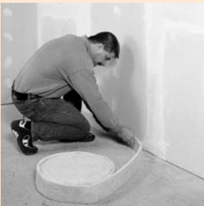
Aufbringen der Randdämmstreifen
