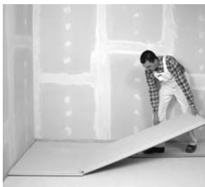
Verlegen der FERMACELL Estrich-Elemente auf FERMACELL Ausgleichsschüttung
