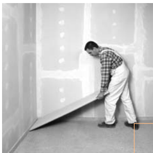
FERMACELL Estrich-Elemente verlegen
