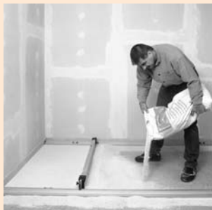
FERMACELL Ausgleichsschüttung einbringen
