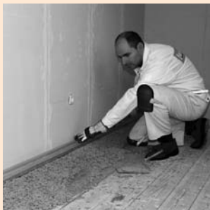
Der erste Damm wird angelegt
