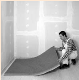
FERMACELL Estrich-Wabe verlegen
