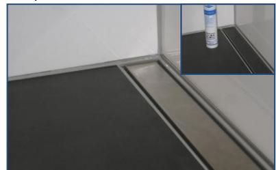
**9.** Rostabdeckung in den Rostrahmen einsetzen. Für eine geflieste Ausführung ist in die Rostabdeckung rückseitig ein Fliesenstreifen mittels Blanke•DIBACOLL zu kleben und in den Rostrahmen einzusetzen. Die Fliesenstärke darf zehn Millimeter nicht überschreiten.
