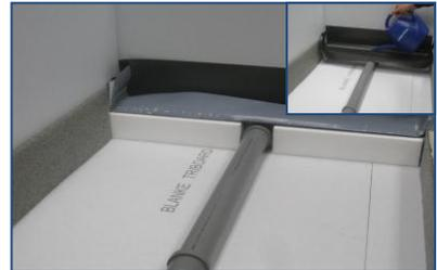
**3.** Blanke•DISK-LINE mit einem Gefälle von 2 % an die Hausentwässerung anschließen und auf Dichtheit überprüfen. Schutzkern im Anschluss in die Linientwässerung einsetzen.
