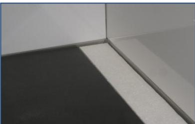
**7.** Der Fliesenbelag ist nach den derzeit gültigen Normen und Regeln im Dünnbettverfahren zu erstellen. Zweite Entwässerungsebene zwischen Bodenbelag und Abdichtungsflansch im Rinnenbereich hohlraumfrei, zementär ausführen. Zur Gestaltung der Übergänge an Wand und Boden stehen unsere Blanke•AQUA Profile zur Verfügung.
