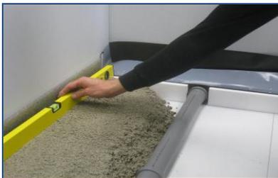
**4.** Zu allen aufsteigenden Bauteilen ist ein Randdämmstreifen zu setzen. Fachgerechten Estrich einbringen und die Oberfläche bündig mit dem Installationsblock abziehen. Die breite Seite des Installationsblocks ist als Abziehle zu verwenden. Ein Gefälle von 2 % ist einzuhalten.
