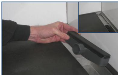
**8.** Schutzkern entfernen und den Siphon von innen in die Blanke•DISK-LINE einstecken. Im Anschluss Rostrahmen mit den mitgelieferten Rosterhöhungsstücken oberflächenbündig einsetzen und den Rostrahmen dauerelastisch mit neutralvernetztem Silikon zu den Wand- und Bodenfliesen versiegeln.
