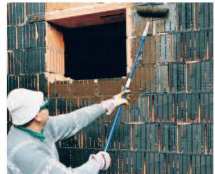
PCI Pecimor F, 1 : 5 mit Wasser verdünnt, als Grundierung für eine Bauwerksabdichtung mit kunststoffmodifizierter Bitumendickbeschichtung nach DIN 18 195.
