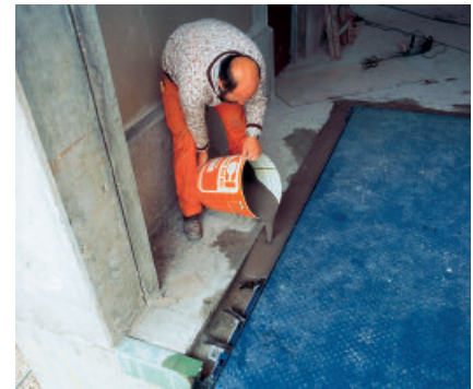
Kraftschlüssiger Verguss von Einbauteilen mit PCI Repaflow Turbo am Beispiel einer Laderampe.
