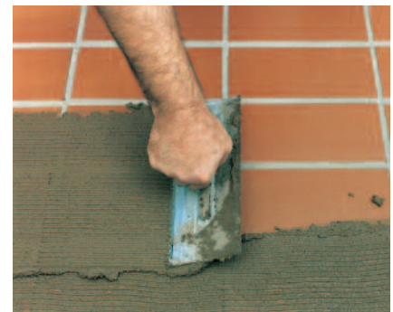
PCI Polyhaft ergibt eine griffige Haftbrücke für Fliesenverlegemörtel auf glatten, dichten Untergründen, z. B. auf alten Keramikbelägen.
