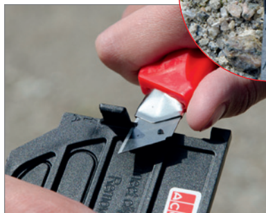
2. Klip A links und rechts mit dem Cutter entfernen
