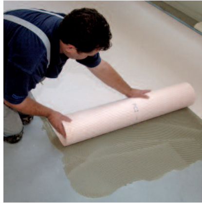
werden die PCI Pecilastic-Bahnen eingelegt...
