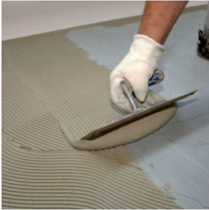
In das frisch aufgekämmte Kleberbett...
