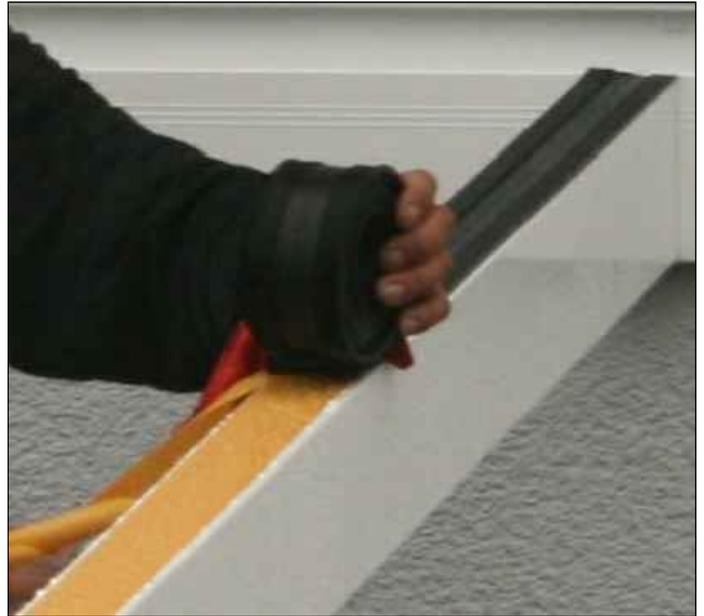
Das Unterlegband mit Hilfe des doppelseitigen Klebebandes auf den Sparren verlegen.
