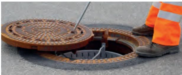
Auflageflächen an Deckel und Rahmen reinigen. Deckel, Rahmen, dämpfende Einlage und Verriegelungsnocken auf Beschädigungen überprüfen, und Deckel unter Beachtung der Einlegesicherung einlegen
