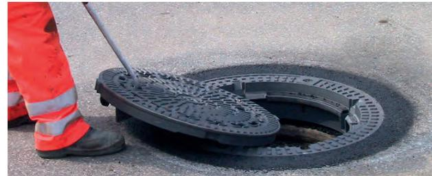
Anschließend den Deckel mit dem Bedienschlüssel an den Aushebeöffnungen herausziehen. Beim Begehen des Schachtes einschlägige Unfallverhütungsvorschriften beachten.
