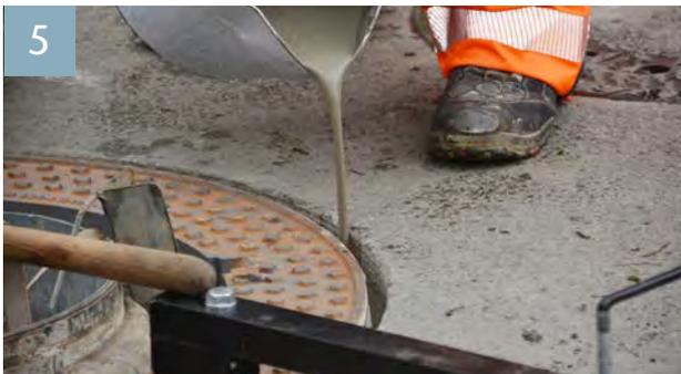
Nach Einbau einer Innenschalung Fugen bis ca. 4 cm unter Oberkante mit Schachtvergussmörtel vergießen
