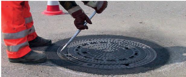
Bedienungsschlüssel an den Entriegelungsöffnungen am Rahmen einsetzen, und mit einer Handbewegung nach außen den Deckel entriegeln
