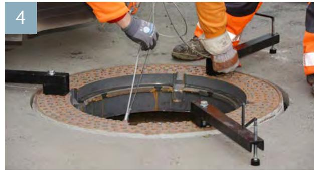
Beguplan Abdeckung einsetzen und auf Höhe ausrichten
