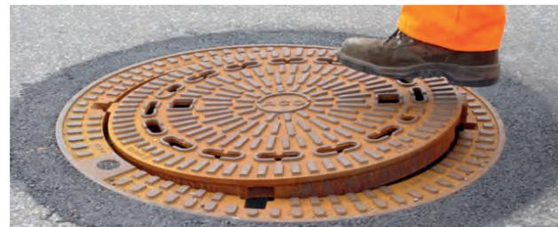
Anschließend Deckel mit einem senkrechten Tritt oder Stoß auf den über den Rahmen hinausragenden Teil des Deckels verriegeln. Die Verriegelung ist eingerastet, wenn Deckel und Rahmenoberseite umlaufend auf gleicher Höhe liegen.
