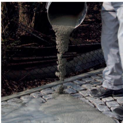
Aufbringen von PCI Pavifix CEM Rapid auf die sorgfältige vorgehängte zu verfugende Fläche.
