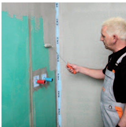
3. PCI Lastogum® in zwei Arbeitsgängen flächendeckend auftragen.
