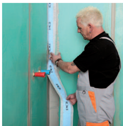
2b. Eck- und Anschlussfugen abdichten. Nachfolgend das Dichtband PCI Pecitape mit leichtem Druck in das noch frische PCI Lastogum einbetten.
