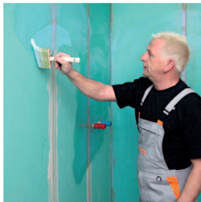
1. Grundierung PCI Gisogrund flächendeckend auftragen.
