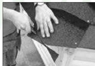
Zum Schluß wird die erste Schindel entlang der Dachtraufe abgeschnitten
