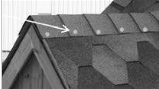
Schindel mit Dachpappennägel befestigen
