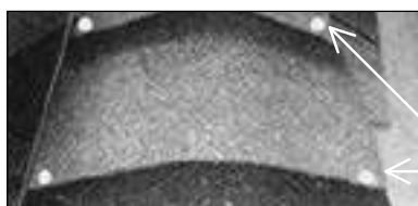
Schindel mit Dachpappennägel befestigen (sichtbar genagelt)
