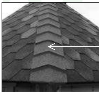
Ansicht Dachgrat fertig montiert
