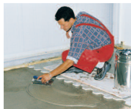
Der ausgegossene Verlegemörtel kann mit einer Zahnkelle leicht verteilt werden.
