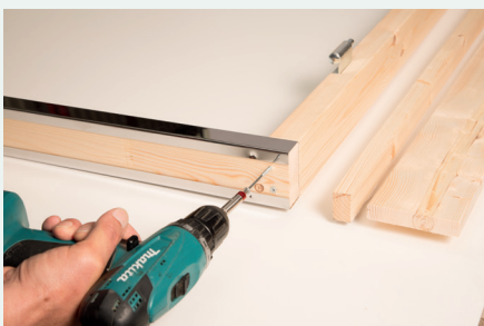
4. Anschrauben der unteren Türschwelle
