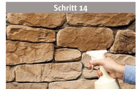
Schützen Sie Außenwände und Feuchträume immer mit unserer Spezial Imprägnierung. Die Wand muss absolut trocken sein. Tragen Sie die Spezial Imprägnierung mittels Sprühflasche oder Quast auf. Die Steinriemchen müssen vollständig gesättigt sein.
