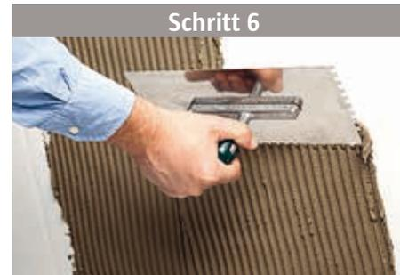
Verteilen Sie den Kleber mit einer Zahnkelle auf eine nicht zu große Fläche, damit er nicht austrocknet, bevor Sie die Steinriemchen verarbeitet haben. Es wird von unten nach oben gearbeitet. 8 mm Zahnung für Murok Strato und alle Riemchen in Backsteinoptik und 10 mm für alle anderen Murok Riemchen und Atlas.
