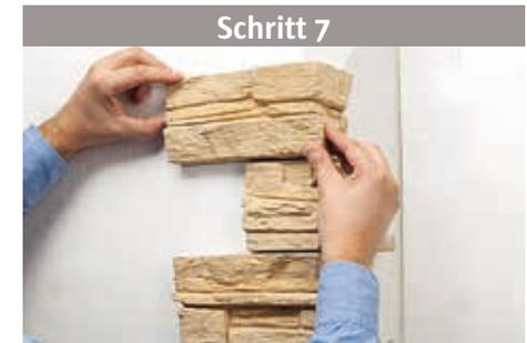
Wenn Eckriemchen verarbeitet werden sollen, achten Sie darauf, mit diesen bei der Verlegung zu beginnen. Es wird von unten nach oben gearbeitet. Die Eckriemchen wechselweise verlegen, damit keine Kreuzfugen entstehen.
