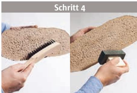
Die Rückseiten der Steinriemchen müssen vor der Verarbeitung mittels Drahtbürste von eventuellen Produktionsrückständen oder Staub gereinigt werden. Eventuelle Graten an den Rändern sind mittels Schleifstein vor der Verarbeitung zu entfernen.
