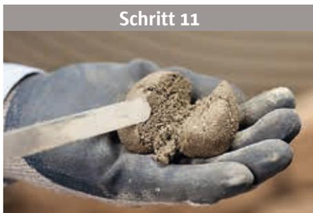
Das Verfugen erfolgt mit Unijoint Fugenmörtel. Der Fugenmörtel sollte eine erdfuchte Konsistenz haben. Benutzen Sie immer die gleiche Menge Wasser zum Anmischen, um Farbunterschiede zu vermeiden.
