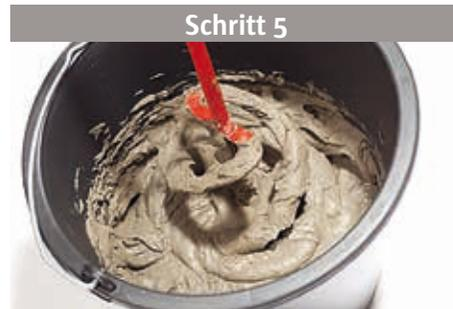
Rühren Sie den Kleber gemäß Vorgabe in einem Mauerkübel mit einem Rührgerät/Quirl an.
