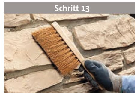
Entfernen Sie überschüssigen Kleber mit einem Handfeger oder einer Bürste, bevor er aushärtet.
