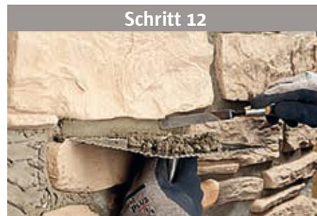
Den Fugenmörtel mit einem Fugeisen oder Schlauch verteilen und glattstreichen. Die vertikalen Fugen sind normalerweise etwas dünner als die horizontalen. Wenn die Steine ohne Verfugung verlegt werden sollen, ist darauf zu achten, dass der noch feuchte Kleber zwischen den Steinen mittels Pinsel glatt gestrichen wird.
