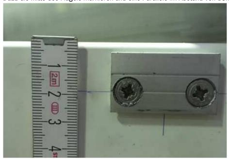
Die Anschraubplatte (T-Schiene) genau mittig auf dem Flügel wie auf der Zeichnung mit den zwei Schnellbauschrauben 5x25 anschrauben.
