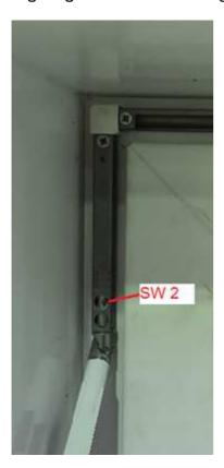
Oberes Glenklager in Eckumlenkung schieben und mit Madenschraube SW2 sichern.
