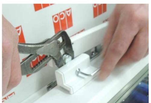
Halbrundkopfschraube am Flügelbock lösen (Sechskantschlüssel SW3), Kurbel weiter betätigen bis die Schere vollständig geschlossen ist. Dabei durch Drehen am Hebel unterstützen. Hebel mit Gabelschlüssel SW12 oder Zange soweit drehen, bis der Flügel Andruck hat. Schraube fest anziehen.
