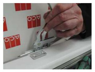
Schere von der Rückseite in die Schiene einfädeln und bis zur Feder schieben. Dabei über die Koppelstange schieben.
