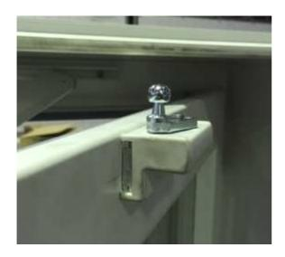
Es ist hilfreich, den Flügel zuerst zu montieren. Dieser ist gegen Herausfallen zu sichern. Dazu die Mitte des Flügels markieren und eine Parallele im Abstand von 18mm anzeichnen.
